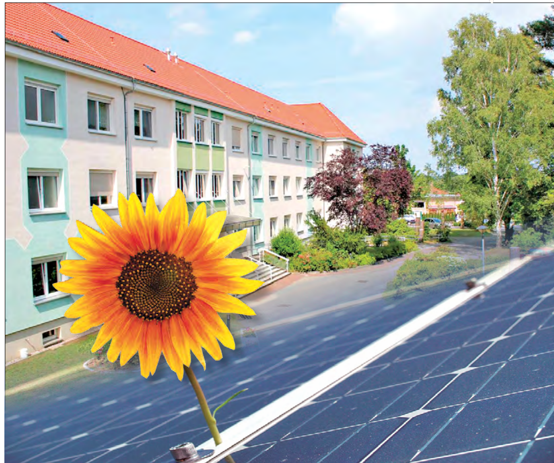
Auf dem Dach des Altenpflegeheims „Rosa Thälmann“ wird schon bald eine leistungsstarke Photovoltaikanlage klimafreundliche Energie erzeugen.
