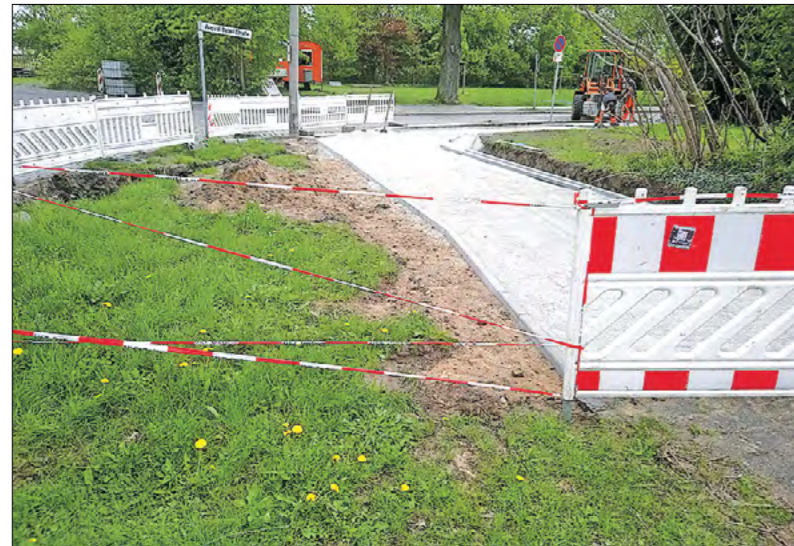
Regelmäßig nutzt die EVG im Rahmen von Straßenerneuerungen die Möglichkeit, Leitungen auszutauschen oder neu zu verlegen. Foto: Drewitz/EVG
